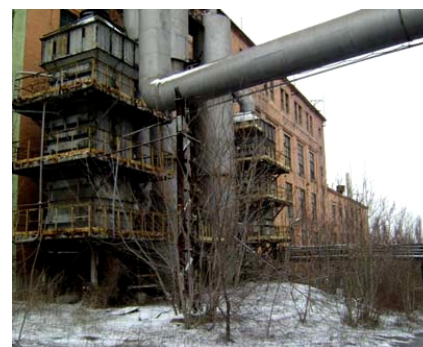
5-5. Споруда 6, цех з вилучення урану Building 6, workshop for extraction of uranium
