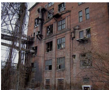
5-4. Споруда 2Б, цех екстракції урану Building 2B, uranium extraction workshop
