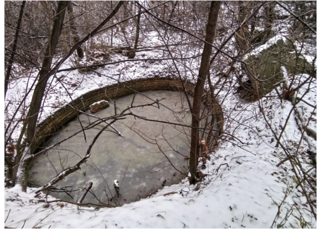
6-2. Протипожежний басейн Fire protection pool
