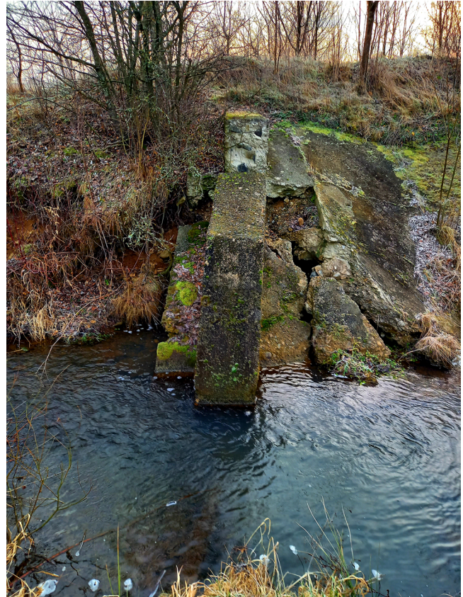
Рис. 17. Напівзруйнована бетонна споруда штучного водоспаду. Фото 17, 18 – Т. Лаврук, 2024. Fig. 17. A half-destroyed concrete structure of an artificial waterfall. Photos 17, 18 – by T. Lavruk, 2024.
